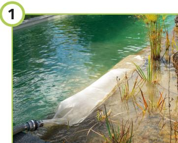
Feinfiltersack ausbreiten und in die Regenerationszone legen. Achten Sie darauf, dass keine spitzen Steine oder Gegenstände unter dem Feinfiltersack liegen. Der Reißverschluss muss dafür verschlossen bleiben.
