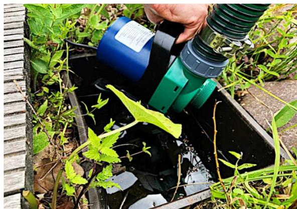
Die Pumpe wird nur druckseitig mit dem Druckrohr verschraubt, während die Saugseite frei im Pumpenschacht hängt. In diesem Fall wurde eine Druckleitung an die Pumpe angeschlossen.
