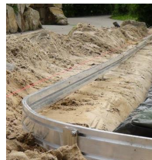
Verlegen mit Bogen
