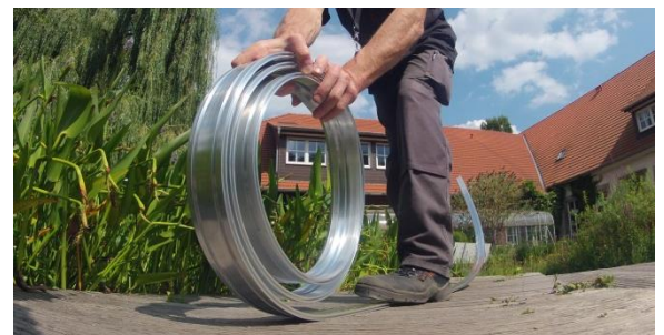
Abrollen des Uferbandes
