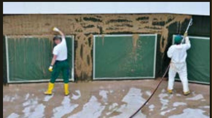
Die Teichfolie wurde mit der Verbundmatte und Mörtel gepanzert. Der Mörtel wird bis in eine Höhe von 2,5 m aufgespritzt.
