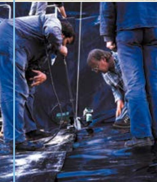
NaturaGart-Mitarbeiter verschweißen vorgefertigte Folienbahnen in der Grube.
