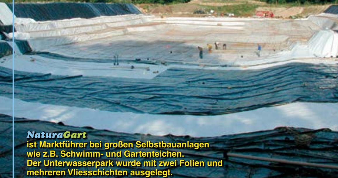
**NaturaGart** ist Marktführer bei großen Selbstbauanlagen wie z.B. Schwimm- und Gartenteichen. Der Unterwasserpark wurde mit zwei Folien und mehreren Vliesschichten ausgelegt.
