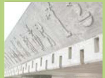
Feinheiten auch am Tempel: Die alt-ägyptischen Zeichen wurden in die Schalung geätzt und betoniert. Die 5 m hohe Säulenhalle hat daher ein 'stilechtes' Dach.
