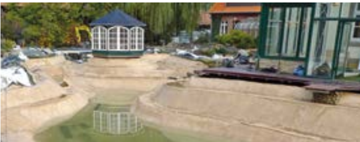
▲ Glätten der Oberfläche in einem Schwimmteich.
