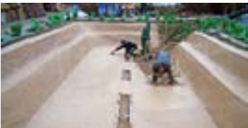
▲ Glätten der Oberfläche in einem Schwimmteich.
