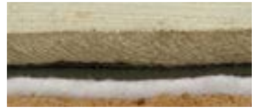
▲ So wird der Teich belastbar dicht: Vlies, Folie, Verbundmatte, dünne Mörtelschicht.
