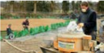
▲ Mörtel von Hand aufbringen oder mit einer Verputzmaschine.
